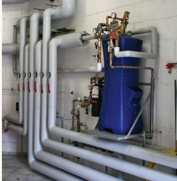
Der Enwa-Matic-Filter benötigt keine Chemikalien, um eine gute Qualität des Heizwassers zu gewährleisten.
